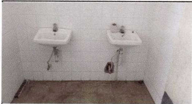
Foto 9: Sustrucción de lavamanos.
