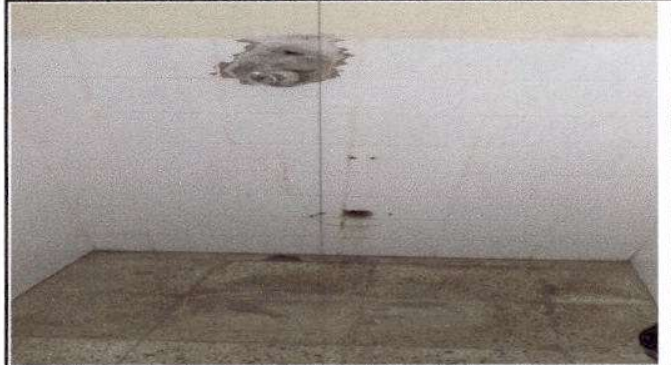
Foto 2: Mantenimiento de piso de granito.
