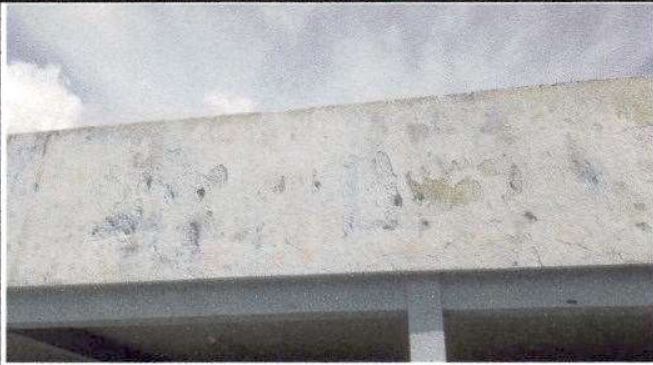
Foto 1: Reparación de repello y sernido de paredes.
