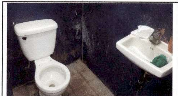
Foto 10: Sustrucción de inodoro.
