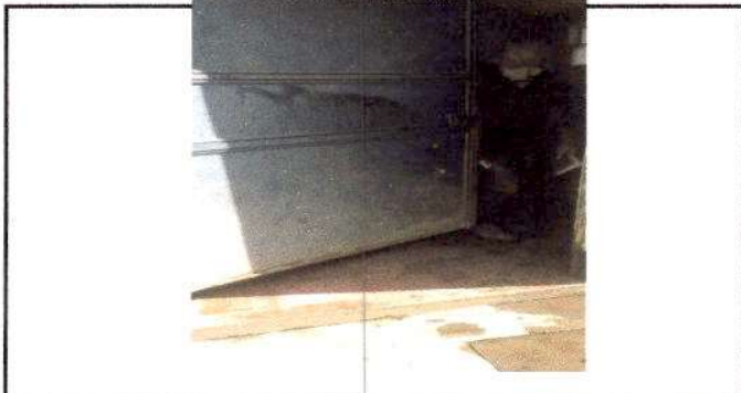
Foto 6: Sustitución de puertas en servicio sanitario.
