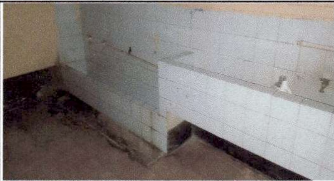
Foto 3: Reparación de red de drenaje y red de agua potable.
