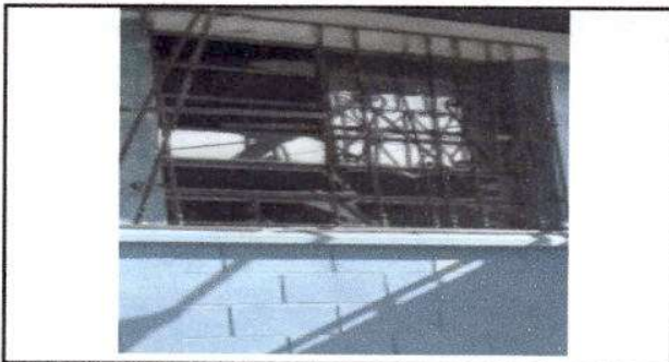
Foto 11: Sustrucción de balcones de metal.
